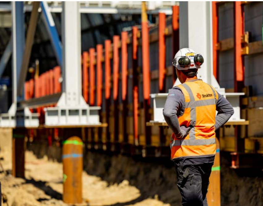
Het werk bevat zowel spoorse, als civiele werkzaamheden. (Beeld: Jason Setzer)
